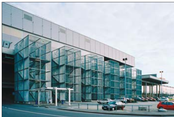
Escaliers de secours côté Aéroport
