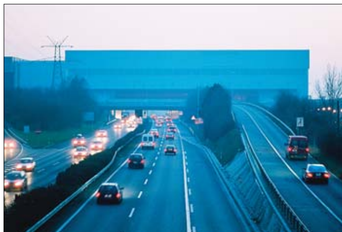
Façade côté Lausanne
